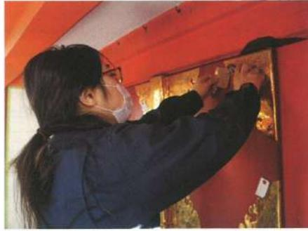
今年度は、単色塗研修と同じ芸能神社本殿にて、鋳金具の状況確認、取外し及び欠損金具の新補に伴う型取り作業を行いました。屋根回りの金具の取外が高所作業となる為、講師の指導の元、安全配慮に努め取外作業を行いました。金具の補修、欠損分の新補につきましては、次年度で実施の予定です。
