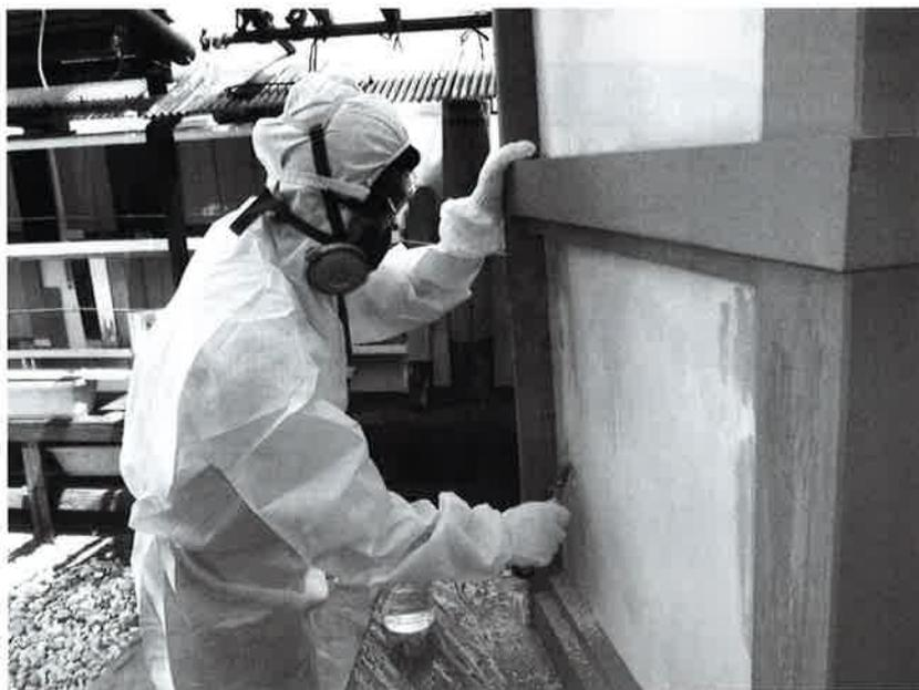
(株)片山では、清水寺と毘沙門堂の修復現場の見学、及び社内での実習を行いました。実習では丹塗り模型を用いて、実際の作業と同じ様に掻き落とし・水拭き・胡粉、鉛丹の塗装材料作り・礬水引き・下塗り・上塗りをしました。
